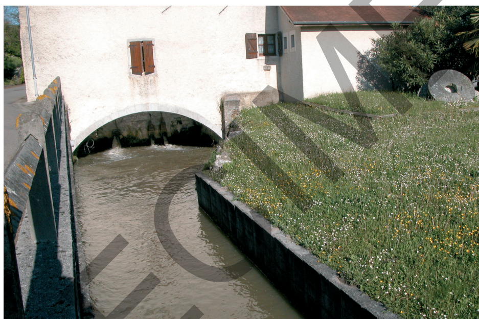
Le moulin d'Abidos et son canal de fuite.
