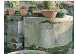
Puits Guichebarou à godets, profond de 21 m. Admirer le logement dans la margelle permettant au puseur de tourner plus à l'aise la manivelle.
