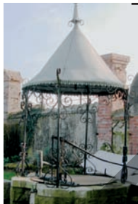
Puits Brincas A l'origine à treuil, puis équipé d'une pompe aspirante manuelle, enfin d'une moto-pompe.
