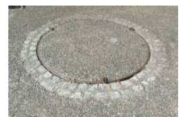
Puits Cauchapé La margelle du puits a été supprimée, une moto-pompe installée l'eau est utilisée pour les gros nettoyages.
