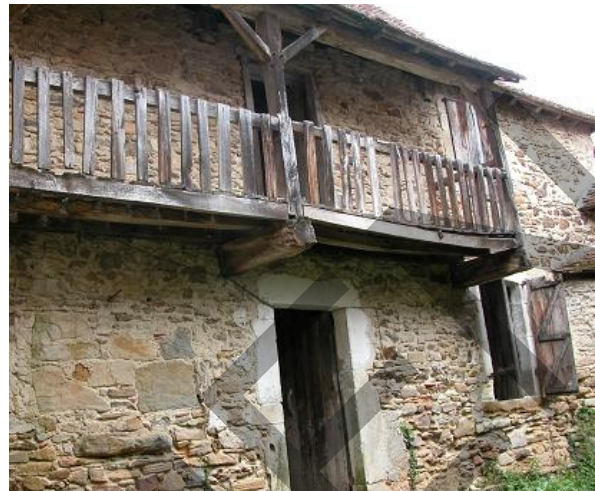
Murs en cailloux - Linteau de porte en pierre taillée (16e- 17e) Galerie qui mène au grenier et aux chambres de l'étage. Le linteau cintré de la fenêtre date du 19e siècle. Un four à pain devait se trouver à gauche de la porte. Son ouverture a été comblée par de grosses pierres.
