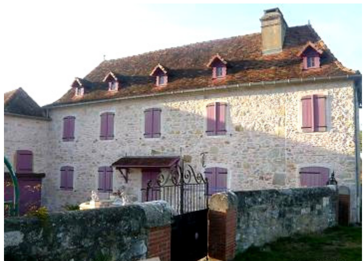
La maison a subi plusieurs agrandissements rendus visibles par le décrépiage des murs. La souche de la cheminée témoigne de l'ancienneté de la maison. - Symétrie des ouvertures et grange accolée en équerre.
